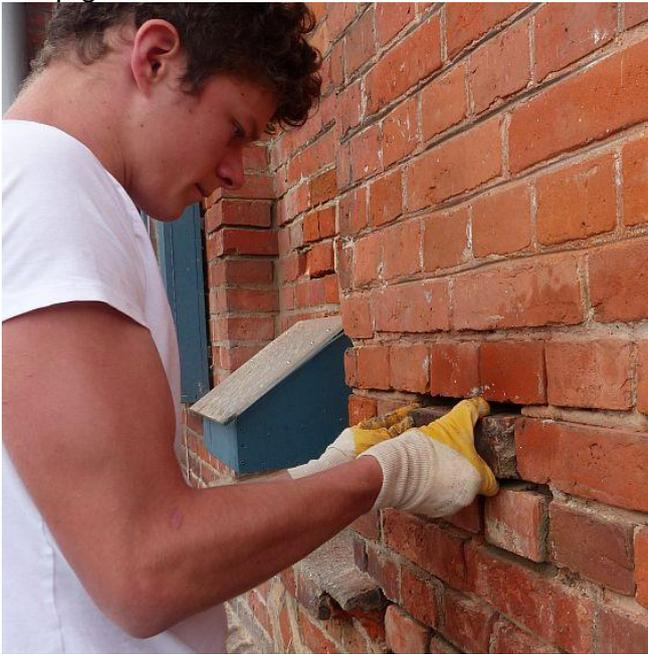
Die Steine wurden mit Zementmörtel eingesetzt und dann mit hydraulischen Kalkmörtel verfügt.
