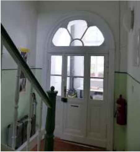
Eingangstür vom Treppenhaus zum Eingangsbereich. (Foto 11: 2026)
