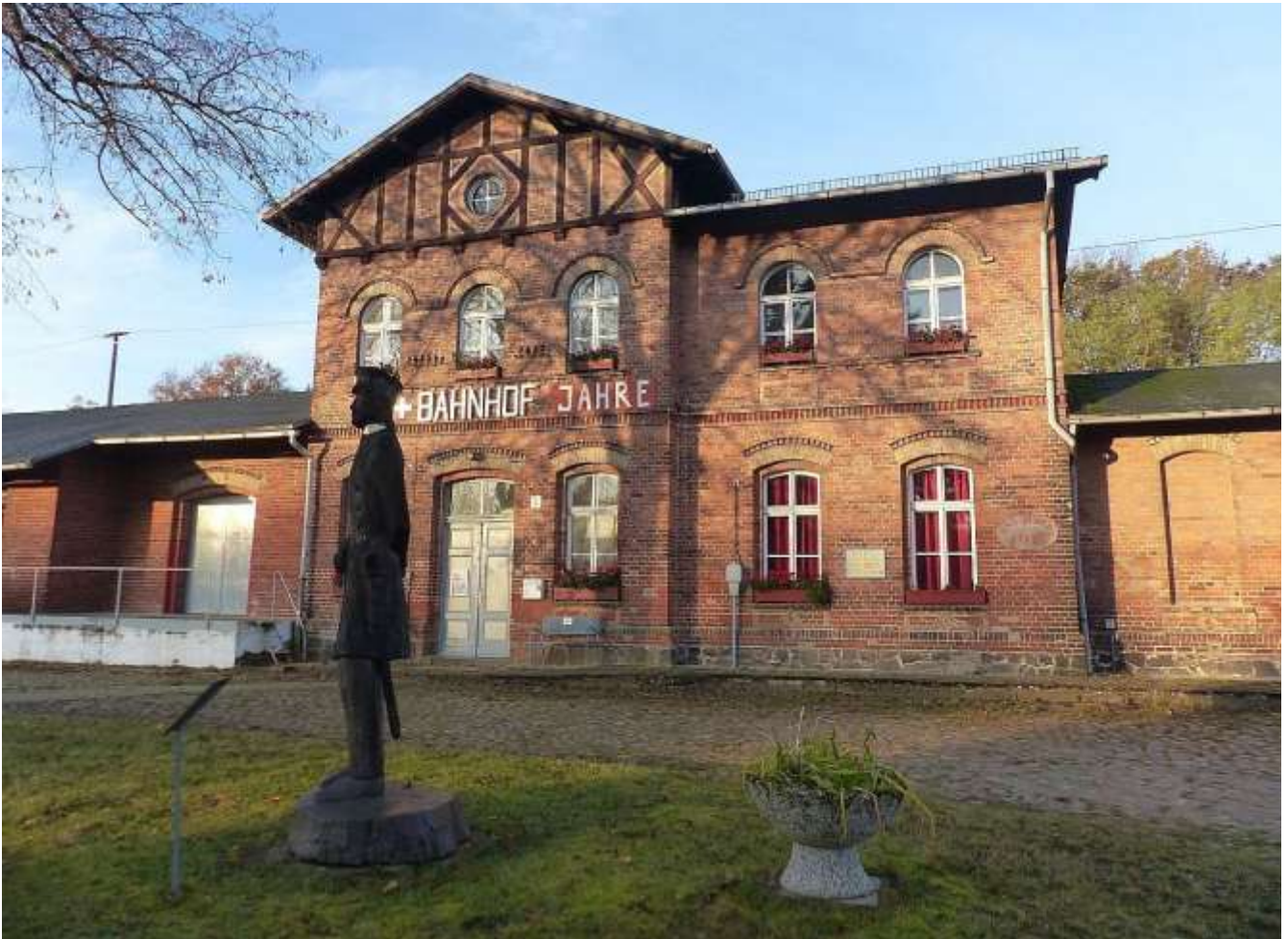
Bahnhofs-Hauptgebäude nach der Sanierung des Mauerwerks: Links der Güterboden, rechts die Alte Bahnhofsstube, oben die Badezimmer, die Tee-Küche und Schlafräume. (Foto 1:2021)
