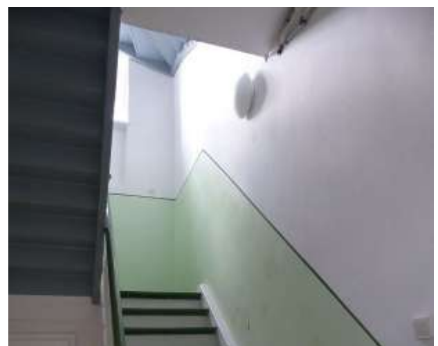
Das Treppenhaus wurde entkernt, neu beleuchtet und mit der ursprünglichen Wandfarbe renoviert. Die Stufen wurden verlängert, das Geländer in der ursprünglichen dunkleren Grün-Farbe lackiert. (Foto 24: 2023)
