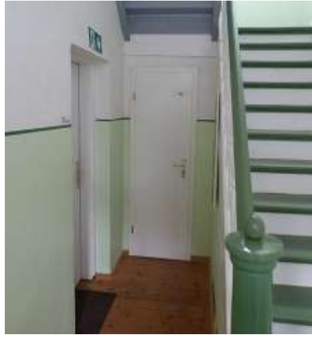
Treppenhaus-Flur zum WC und zur Neuen Bahnstube, linke Tür. (Foto 12: 2026)
