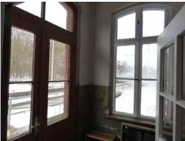
Der ehemalige Bahnsteigeingang für Bahnbedienstete ist noch nicht renoviert. Hier ist bisher nur ein kleiner Sitzplatz geplant. (Foto 16: 2026)
