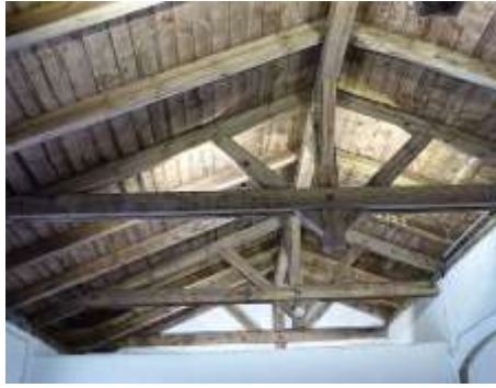
Die Beleuchtung des Dachgebälks verleiht dem Güterboden neuen Charme. (Foto 19: 2020)
