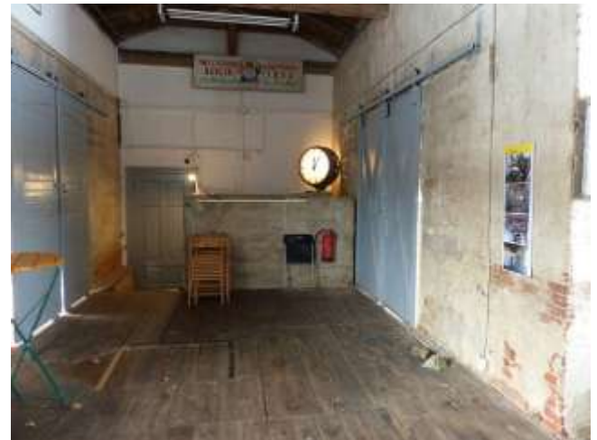
Der Güterboden mit seinen zwei Schiebetüren, rechts zur sogenannten Kunstrampe und links zur schmalen Rampe auf der Gleisseite. Im Hintergrund ein kleiner Bunker. (Foto 22: 2026)
