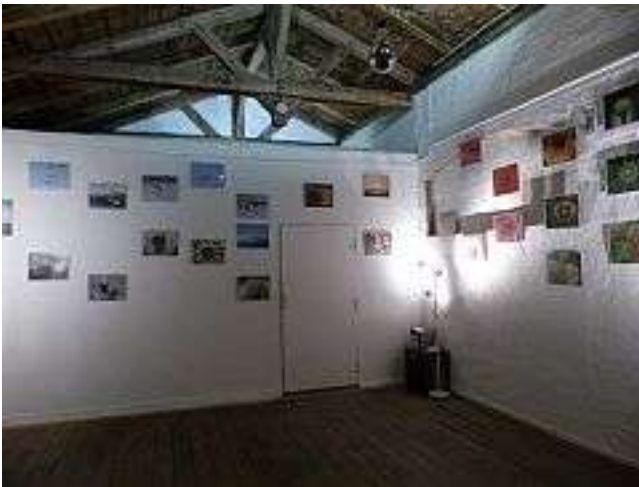
Die Rückwand des Güterbodens bei einer Ausstellung von Naturfotografien. Die Wände sind etwa zur Hälfte weiß gestrichen, zur anderen Hälfte in Mauerwerk und Teilverputzung lediglich verfestigt. (Foto 21: 2022)
