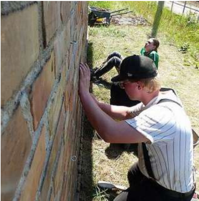
Das ehemalige Bahnhofstoiletten-Gebäude hatte sich gesenkt. Es war ein breiter Riss neu zu füllen.
