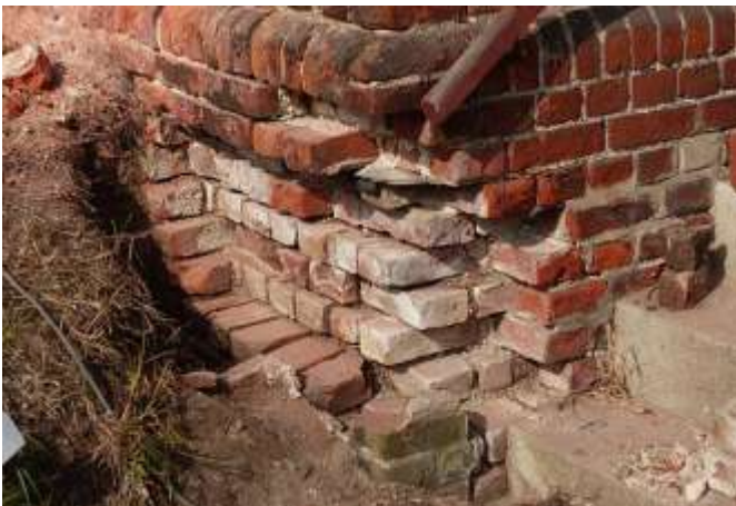
Die Gebäude-Ecke war durch Regenwasser ausgespült, die Teerpappe zerstört.
