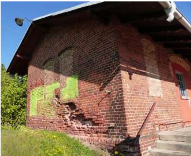
Ursache der Maßnahme war die Südwand der Güterhalle. Abgesehen von den Wandschmierereien war auf einer Länge von knapp drei Metern fast gar keine Bausubstanz mehr vorhanden.
