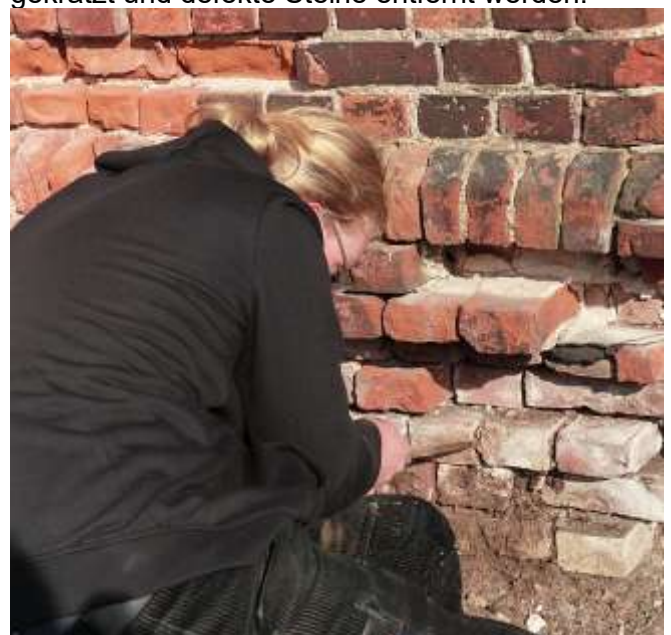
Das war teilweise sehr mühsam, da mit Hammer und Meißel nur schwer an die abzuschlagenden Stein- teile heranzukommen war und über die vielen Jahre der Erhaltungsmaßnahmen sehr unterschiedlicher Putz verwendet wurde.
