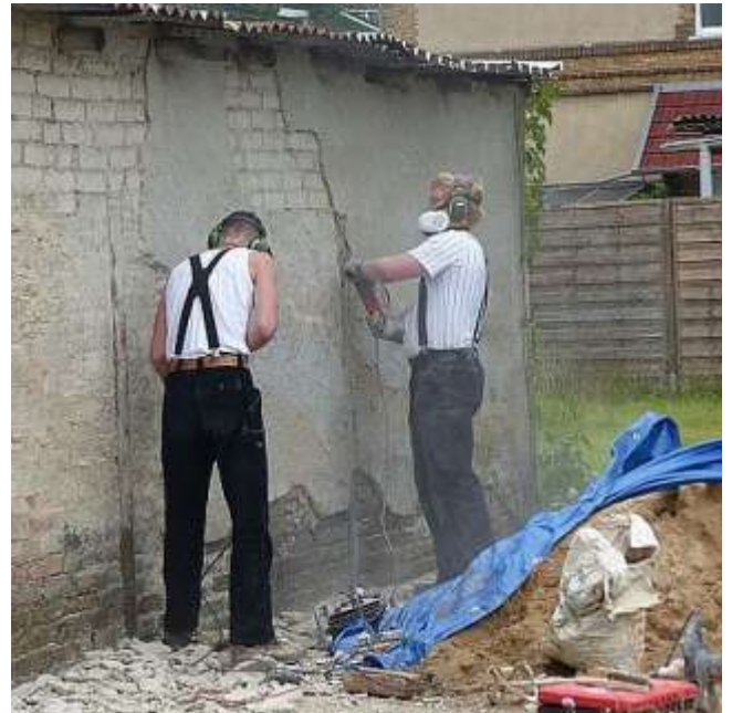
Zum Schluss wurde die defekte Garagenwand neu verputzt.
