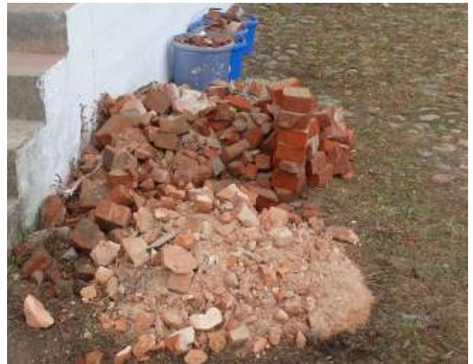
Zuerst mussten brüchiger Mörtel aus den Fugen gekratzt und defekte Steine entfernt werden.
