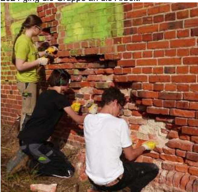
Das war teilweise sehr mühsam, da mit Hammer und Meißel nur schwer an die abzuschlagenden Stein- teile heranzukommen war und über die vielen Jahre der Erhaltungsmaßnahmen sehr unterschiedlicher Putz verwendet wurde.
