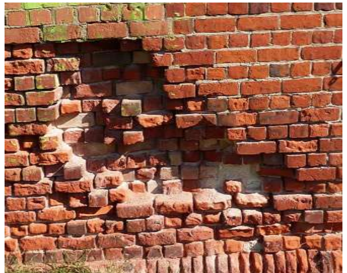
An der extremsten Stelle gab es lediglich einen halben Stein zum Innenraum und in einer Fuge war schon eine Durchsicht zum genutzten Abstell- und Werkzeugraum des Vereins möglich.
