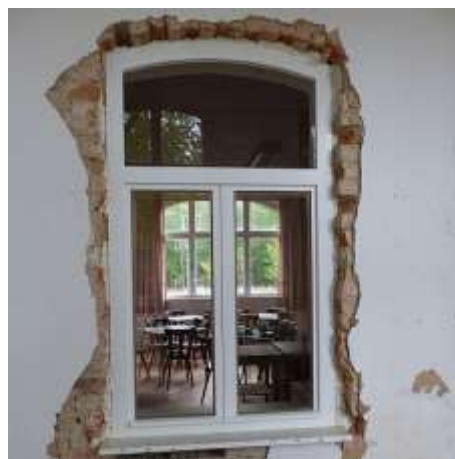
2019 wurde der zugemauerte ehemalige Fahrkartenverkaufs-Schalter wieder geöffnet und mit einem neuen Holzfenster versehen (Foto 15).
