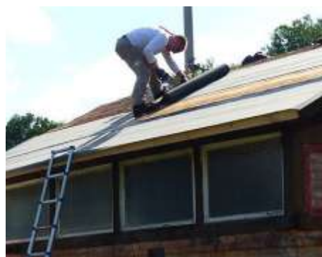
Die Hilfe kam zum rechten Zeitpunkt, die Vereinsmitglieder hätten die Dachdeckung nicht gepackt (Foto 19).
