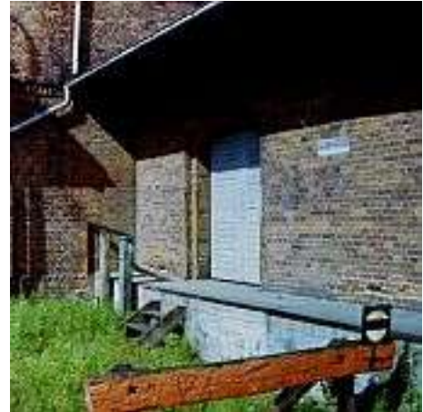
1997/98 war noch Bahnpersonal im Bahnhof und die Außenfront des Hauptgebäudes war recht gut erhalten. Hier ist noch das Gütergleis für die bahnseitige Rampe erkennbar (Foto 1)
