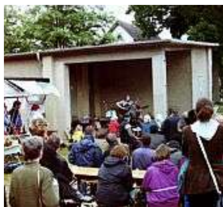
Nördlich direkt am Bahnhofsvorplatz angrenzend stand bis zum Jahr 2006 ein ziemlich unansehnliches Schalthaus der Deutschen Bahn. Ein überdachter Teilbereich wurde vom Verein bei Veranstaltungen als Bühne benutzt, wie hier im Jahr 2001. (Foto 6)
