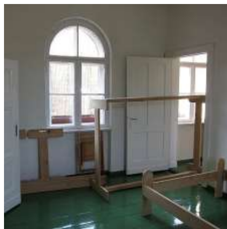
Im Inneren aber wurden allmählich verschiedene Räume renoviert. 2014 erfolgte die Aufstellung der ersten handgefertigten Betten im neu renovierten großen Schlafraum im Obergeschoss mit einem neuen freundlicheren Fußboden (Foto 10).
