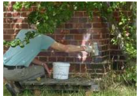
Nach der Sanierung waren einige Quadratmeter Mauerwerk zu verfestigen (Foto 22).
