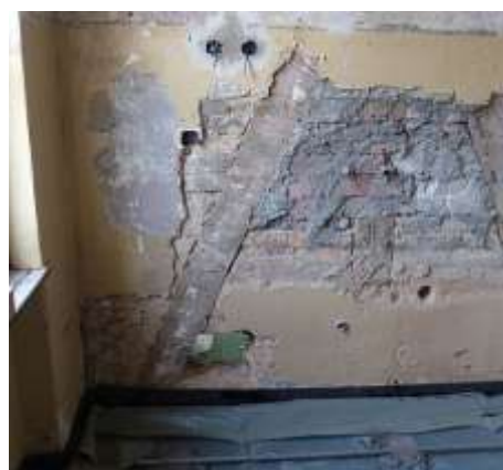
Im Jahr 2021 wurde damit begonnen, in der ehemaligen Küche der Bahnbediensteten im Obergeschoss einen Duschraum für die Ferienwohnung einzurichten (Foto 17).
