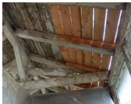
Die Erneuerung der schadhaften Dachteile 2021 war sehr aufwändig (Foto 18).
