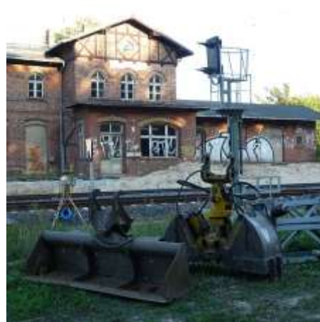
Im Jahr des ersten Bahnsteigneubaus im Jahr 2008 war der Gebäudekomplex von außen in einem überaus desolaten Zustand (Foto 7).
