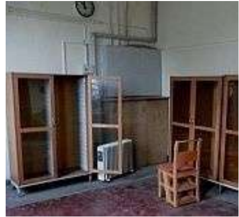
Die in die Jahre gekommene Alte Bahnhofsstube wurde 2023 grundsätzlich renoviert (Foto 20).
