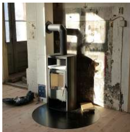
2015 erfolgte die Aufstellung von zwei neuen Kaminöfen im Erdgeschoss und Obergeschoss durch die Stadt Gransee (Foto 12).
