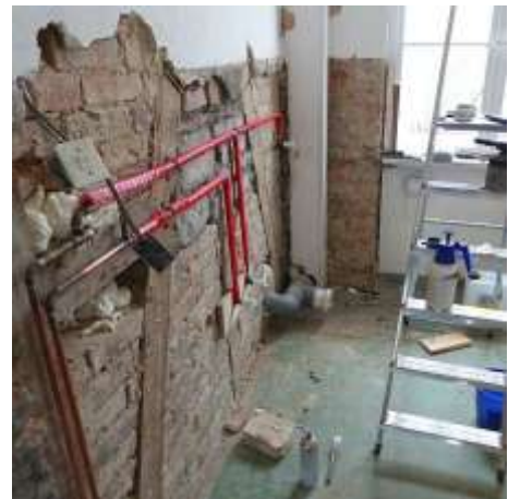
Eine besondere Herausforderung war die Sanierung des ehemaligen Bades 2024 (Foto 21)
